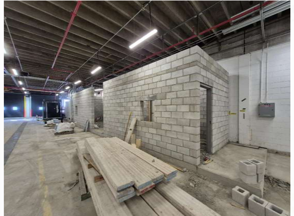
Construction d'une salle électrique
