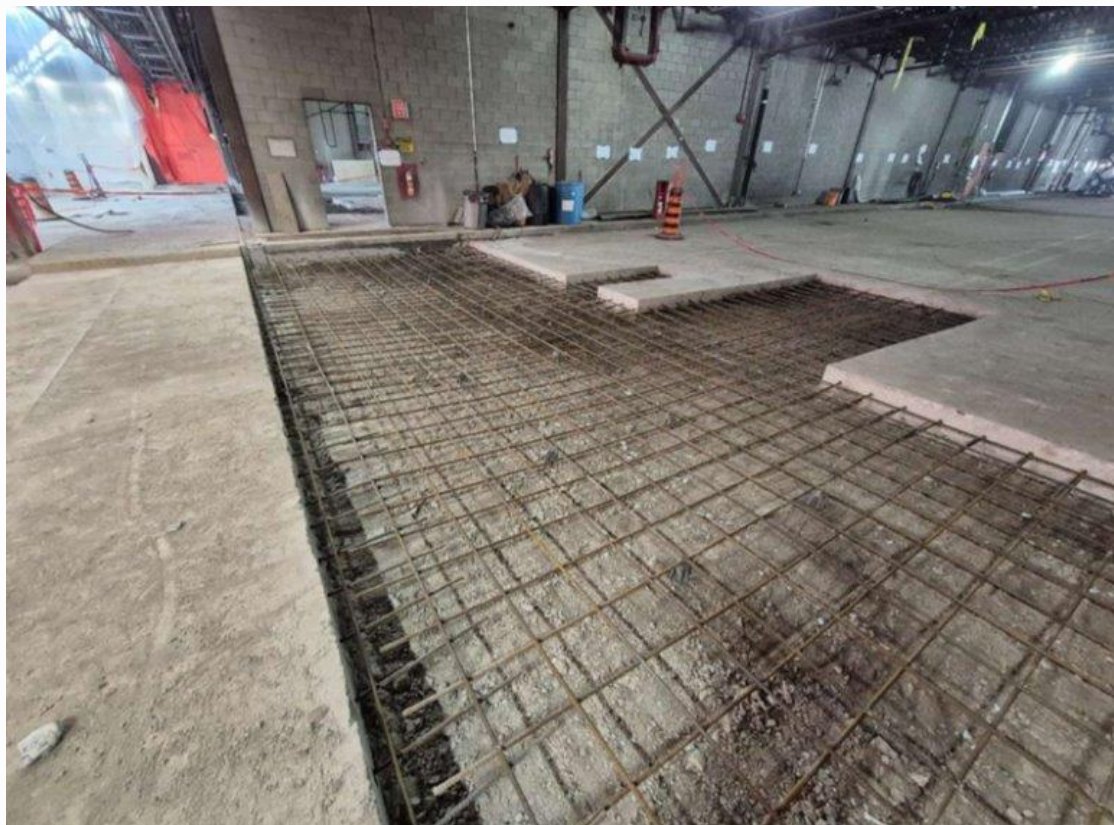
Enlèvement du mur préfabriqué et du plancher
