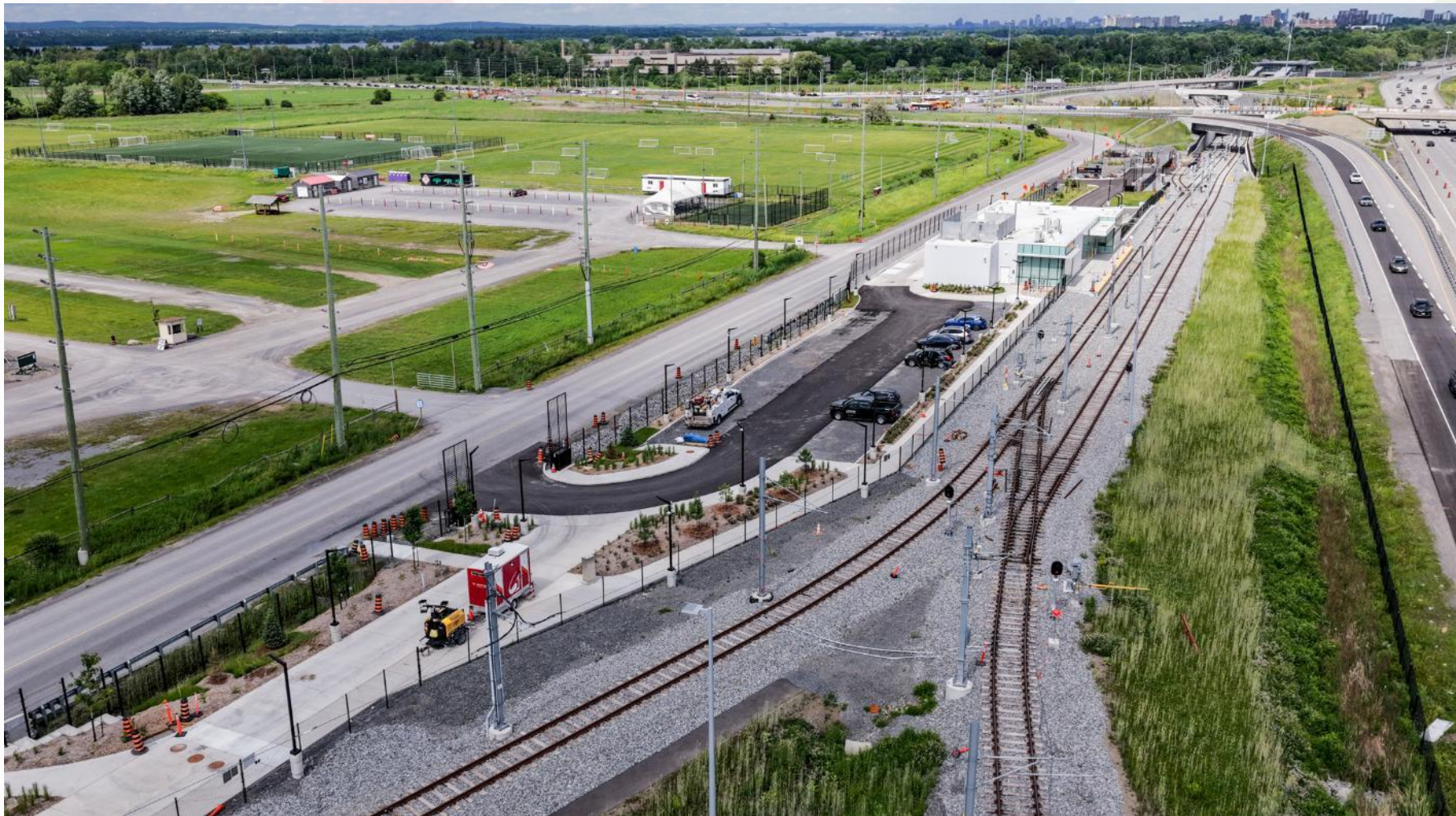
IELR du dépôt Corkstown, vue vers l'est, le 17 juin 2026
