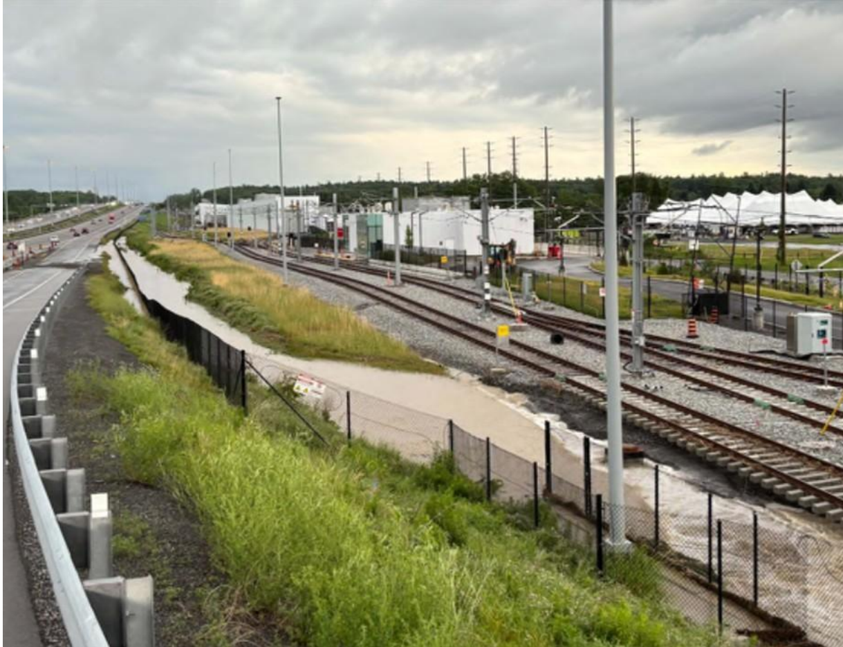
IELR du dépôt Corkstown, vue vers l'ouest
